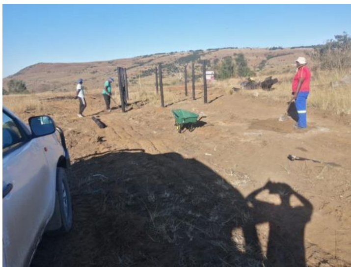
Hekwerk rond bouwkaavel Nquthu stad
